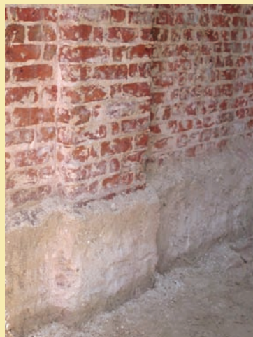
Mur de briques prêt à être enduit à la chaux. Un enduit bâtard a déjà été appliqué en bas du mur au niveau des trottoirs
