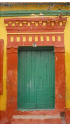
Porte à entablement caissoné
