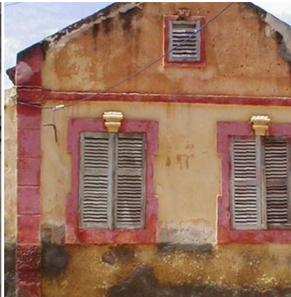
Chaîne d'angle et encadrement des fenêtres
