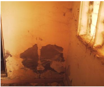
Peinture défectueuse à cause de la salinité du sol
