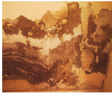
Peinture défectueuse à cause de la salinité du sol
